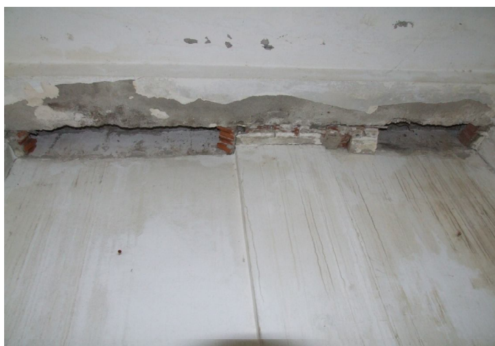
Foto 4. Planșeu spațiu auxiliar de la etajul al-II-lea Pavilion „B2”, unde se vede armătura
